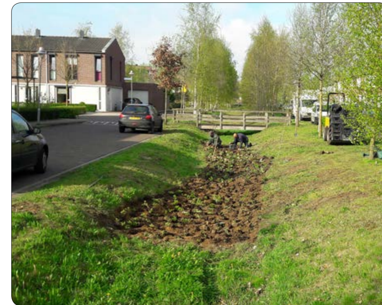
Figuur 1.4: Aanleg beplante wadi Donkervoortseloop te Heesch
