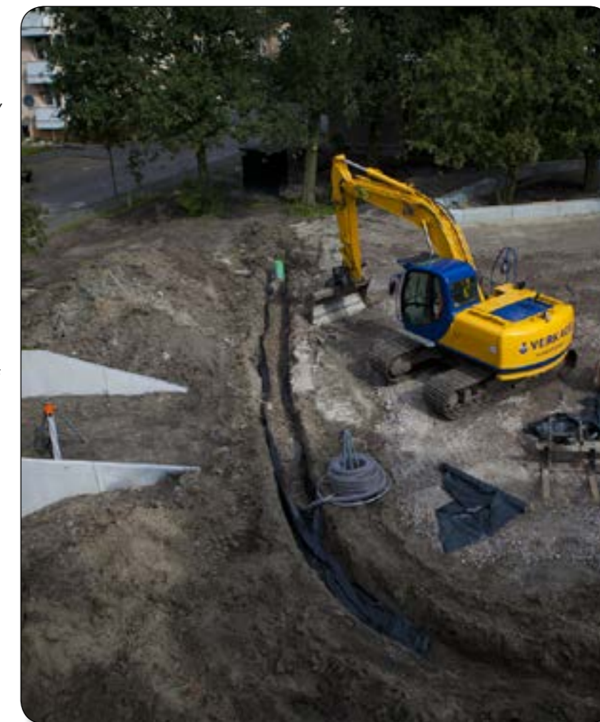
Figuur 2.2: Aanleg wadi ten behoeve van afkoppeling HWA
