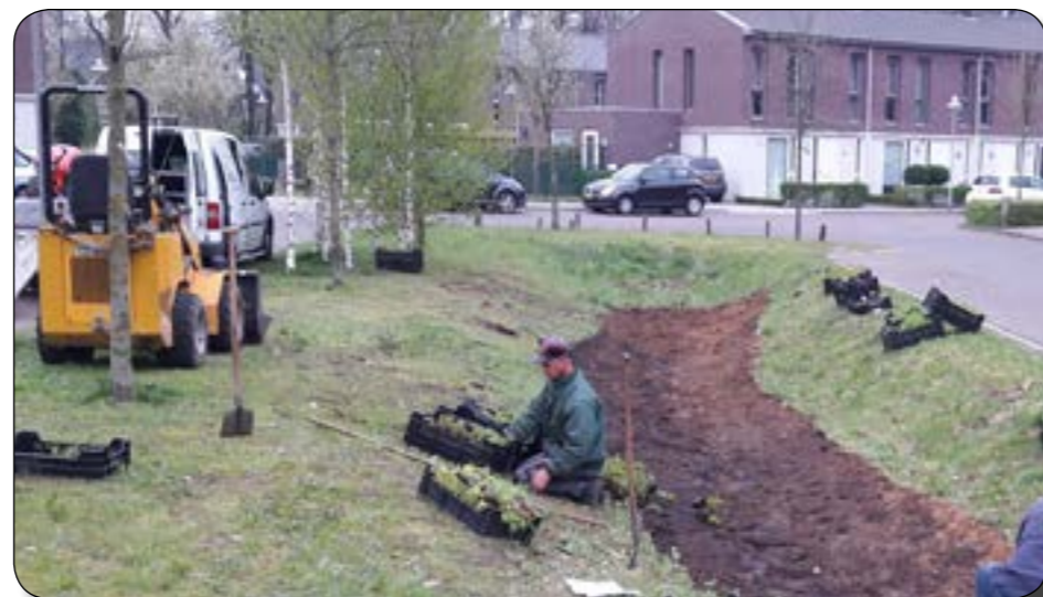
Figuur 8.10: Aanleg proefwadi Donkervoortseleop in Heesch
